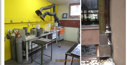
*Abluftanlage in der Metallwerkstatt ist ausser Betrieb, neu ist eine Umluftanlage vorhanden.*
