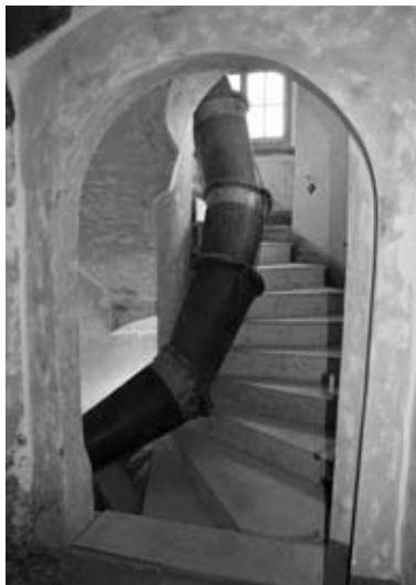
Turmtreppenhaus mit einem Schuttrohr und holzverkleideten Treppenstufen.
