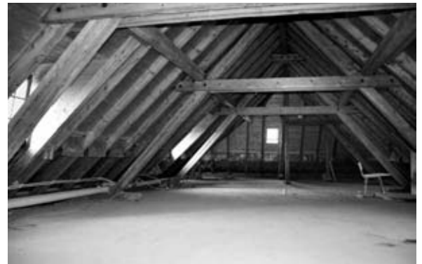
Hier die leer geräumte Dachgeschosswohnung, die zu Atelier-räumen umfunktioniert wird. Auch hier wird der Liftschacht, der etwa auf Höhe des Stuhls in der Mitte des Raums zu stehen kommt, die Grösse des Raums noch einschränken.
