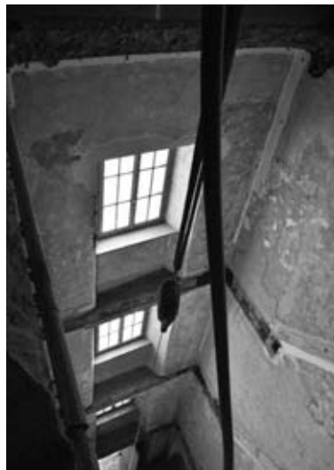
Kanzleitreppenhaus, ohne Lift und Treppe von oben...
