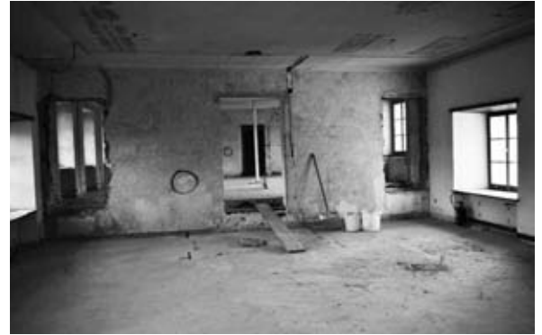
Der Raum, in dem die Kanzlei, der Stadtschreiber untergebracht waren, wird zum grössten Schulzimmer. Vor dem mittleren Durchgang wird aber noch der neue Liftturm eingebaut.
