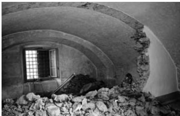
Gewölbe im 1. Obergeschoss, das von der Schule als Aufenthalts- und Leseraum für die Schüler genutzt werden soll. Die Zwischenwand, die das ehemalige Archiv vom Vorraum abgetrennt hat, war glücklicherweise nicht ein tragendes Element und konnte daher einfach abgerissen werden.
