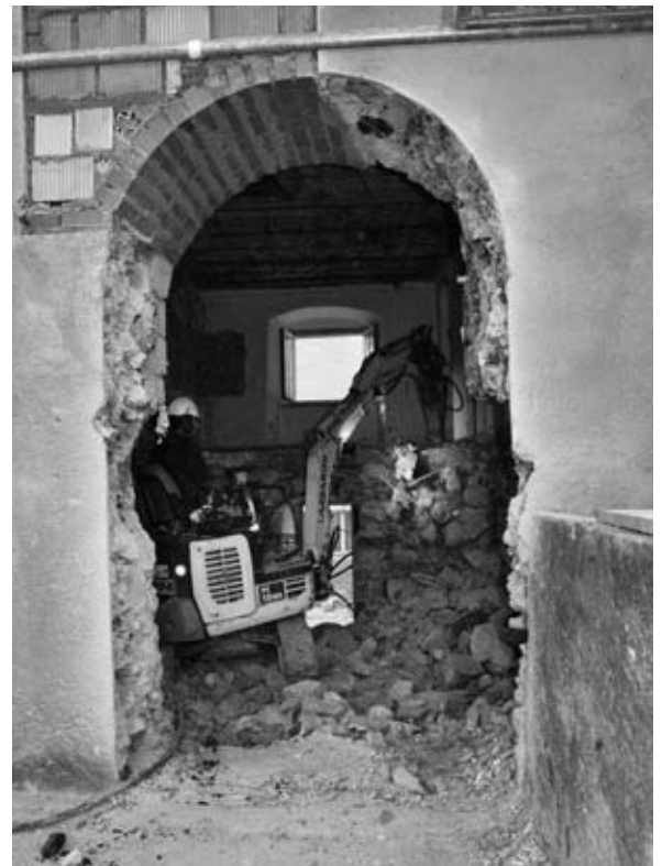
Der Durchbruch für den neuen Ausgang zum Pfandgraben. Hinter dem Bagger unten sieht man die Türe zum Städtli, die zirka fünf Stufen tiefer als der Pfandgraben-Eingang liegt.
