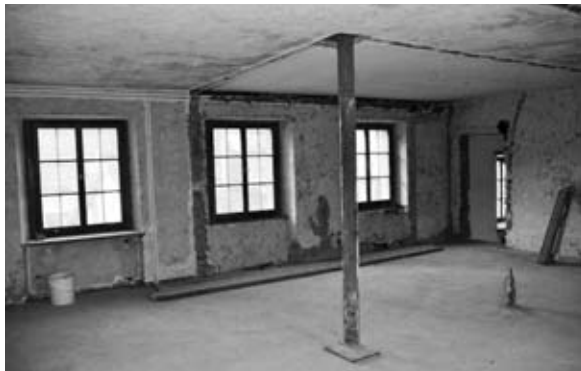
Hier entsteht ein Schulzimmer. An der Decke noch sichtbar der Wandanschluss des ehemaligen Büros des Stadtpräsidenten.
