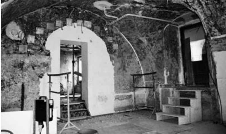
Links der Eingang zum ehemaligen Bauamtsbüro, rechts der Durchgang zur ehemaligen Kanzlei.
