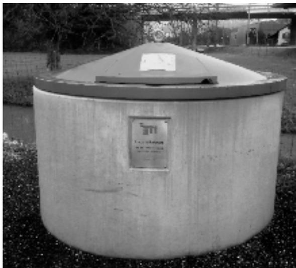
Halbunterflurcontainer des Typs Molok mit dem Einwurfdeckel. Der Sammelcontainer befindet sich im Betonschacht halb ober-/unterirdisch.
